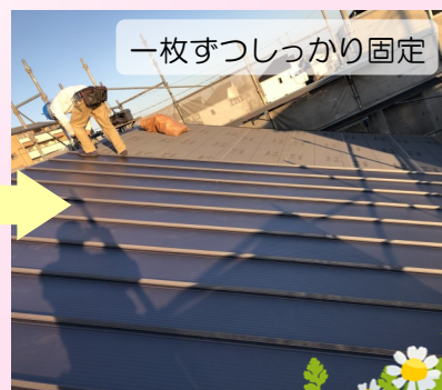
ガルバニウム鋼板を屋根に設置
