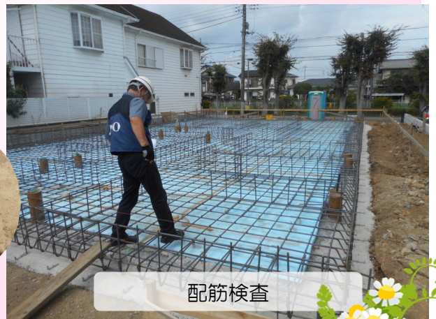
断熱材敷設工事
